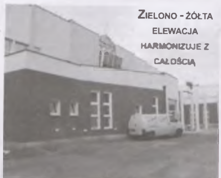
Nowa Hala Sportowa Przy Wronieckim Gimnazjum
