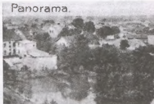
Panorama Wroniek z wieży wodociągowej na pocztówce St. Czosnowskiego z ok. 1905
