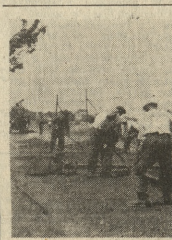
Brygada Ignacego Kasperczaka z rejonu dróg publicznych — Leszno, osiągnęła w bież. roku wysokie normy przy wykonaniu powierzonych jej prac. Na zdjęciu: brygada przy budowie szosy.
