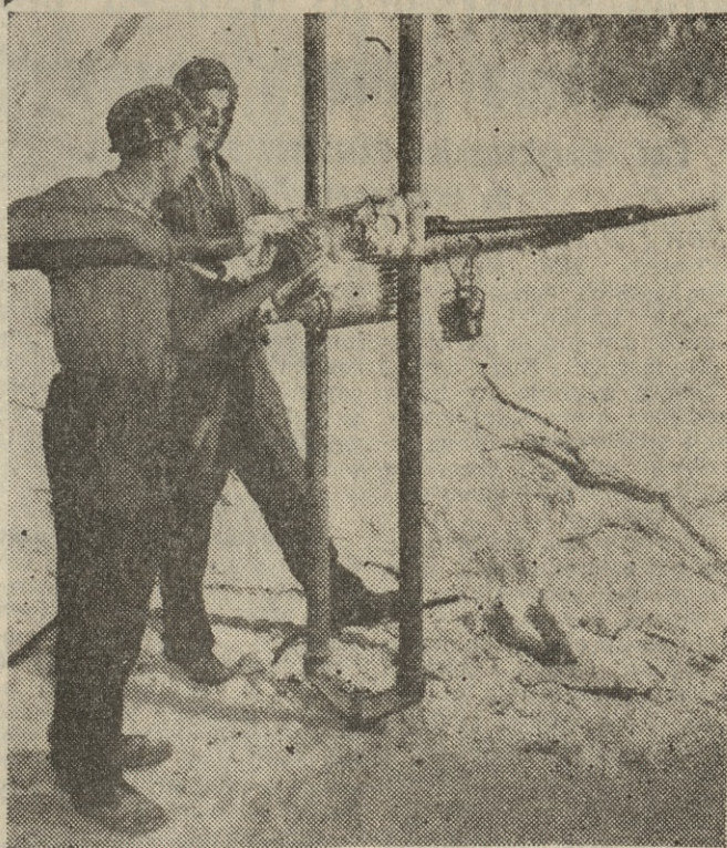
Kopalnia soli w Wapnie wykonała zadania postawione przed nią w planie 6-letnim — w dniu 16. 9. 1955 roku. W planie 5-letnim przewidziana jest dalsza rozbudowa kopalni, co pozwoli na podwojenie produkcji. Na zdjęciu: wiercenie otworów strzelniczych.
