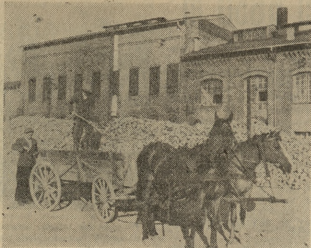
ODSTAWY BURAKÓW CUKROWYCH
