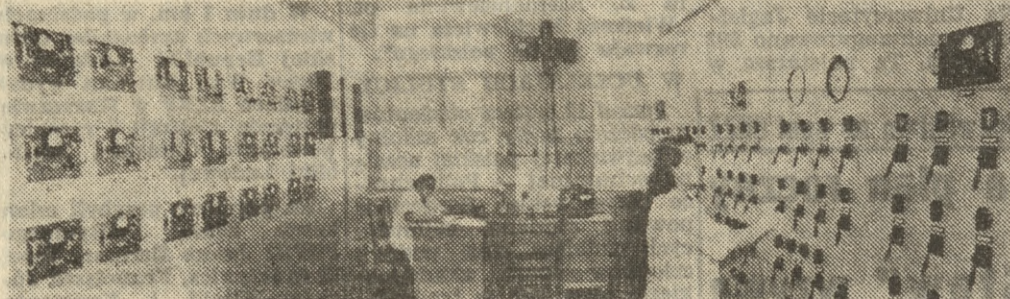
ELEKTROWNIA ATOMOWA W ZSRR Na zdjęciu: centralny punkt dozymetryczny, kontrolujący stan powietrza w pomieszczeniach elektroni.
