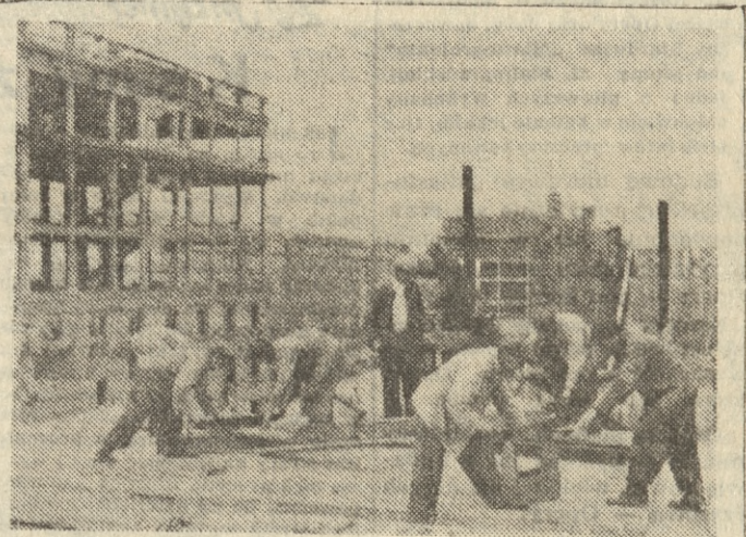
Apel Centralnej Rady Związków Zawodowych znalazł odzew wśród robotników całego kraju. Na zdjęciu: brygada ciepielska Wacława Pnińskiego, pracująca przy budowie przy ulicy Nowotki (Nowy Muranów) zobowiązała się wykonać szalunek IV p. segmentów A i B oraz rozszalować i piętrowy blok do 15. X. 1955 roku. Brygada Pnińskiego osiąga średnio 240% normy.
