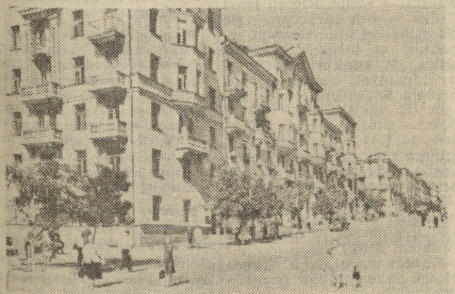
Stalingrad — bohaterskie miasto odbudowane z potwornego zniszczenia. Na zdjęciu: aleja Hutników. W nowych domach mieszkają pracownicy fabryki „Krasnyj Oktiabr”. Fot. — CAF
