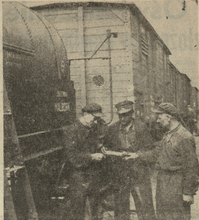
W Lesznie Wlkp. zastosowana została metoda majstra Ryszkowskiego (ZSRR) polegająca na dokonywaniu napraw wagonów na wydzielonych torach, bez potrzeby wycofywania wagonów z ruchu. Dzięki stosowaniu tej metody wagonownia w Lesznie zobowiązała się z okazji „Dnia Kolejarza“ wykonać zadania planu 6-letniego do dnia 13. IX. 1955 r.
