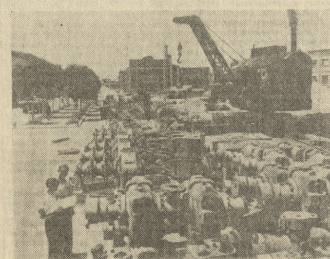
Zakłady budowy urządzeń dla przemysłu naftowego w Ploesti.
