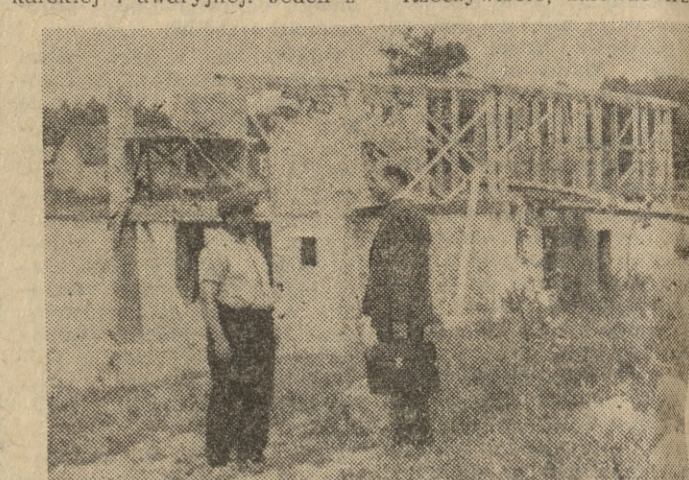
— Zdążymy! — mówi kierownik budowy Kapitańczyk (z lewej) do przewodniczącego sekcji kajakowej WKWF — Michała Kaczmarka.
