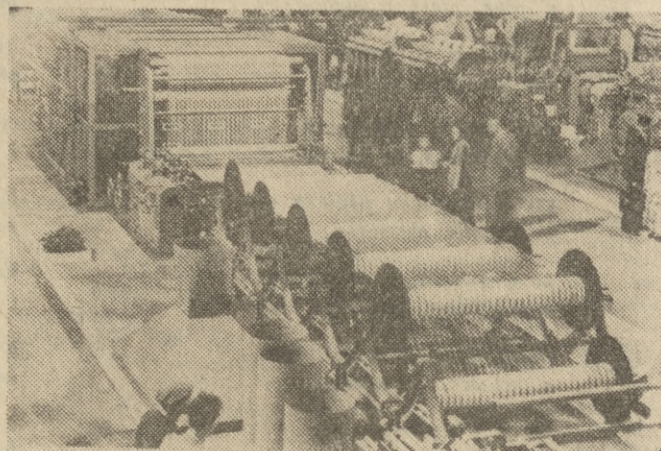
Jedną z zaprezentowanych maszyn przemysłu włókienniczego jest zespół krochmalący EM-1, służący do krochmalenia osnow bawełnianych przed dalszą przeróbką na krosnach. Największa ilość wałów suwalniczych tej maszyny dochodzi do 13.
