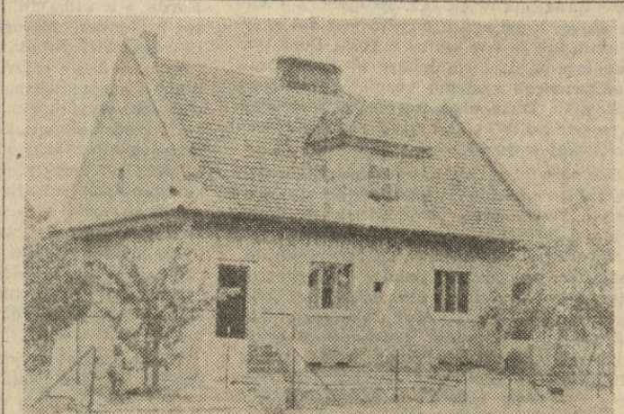
Robotnicy PGR w Naramowicach mieszkają w specjalnej kolonii robotniczej, składającej się z kilkunastu domków jedno- i kilkurodzinnych. Na zdjęciu: bliźniaczy domek jednorodzinny, składający się z 2 pokoi i kuchni. Przy każdym domku znajduje się działka lub ogródek, a niekiedy i budynek gospodarski.
