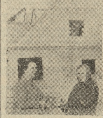
„Parcelkę kupiło się za ośzczędności, cegłę za wspólną pracę nadgodzinową, ścianę postawił teści-murarz, a instalację złożył mąż-technik instalacyjny. No i w 1949 r. przeprowadziliśmy się z jednego pokoju do własnego domu!” — opowiada Henryka Cholewa swojej sąsiadce.
