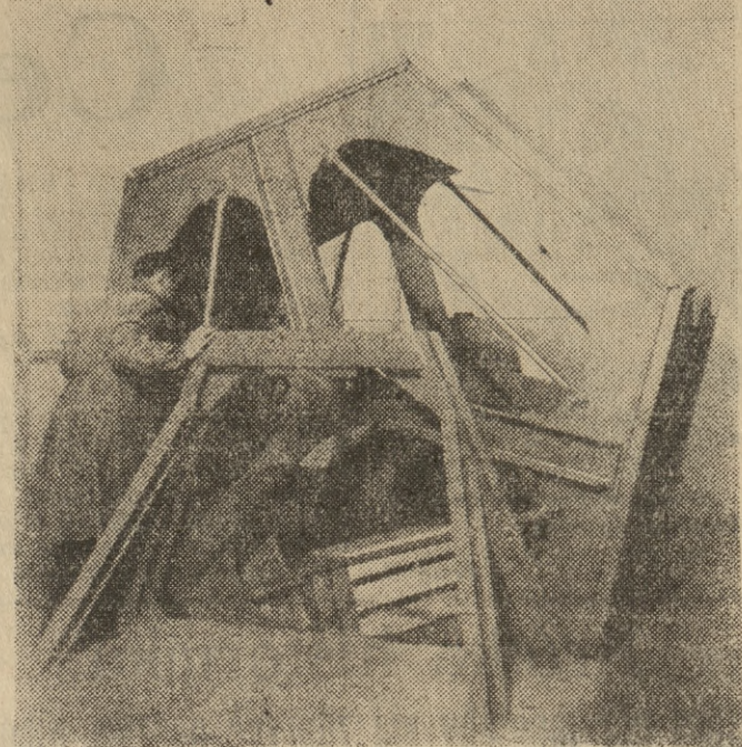
To nie jest wcale skomplikowana maszyna. To po prostu bęben do badania wytrzymałości standardowych modeli skrzyń.
