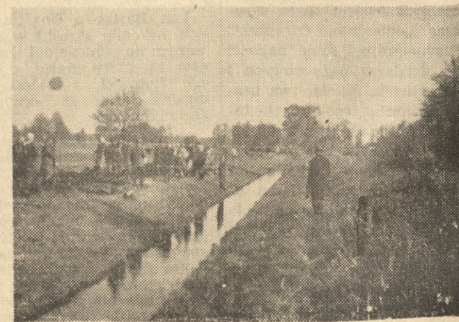
Rów jest już oczyszczony. Teraz trzeba rozrzuć jeszcze mul na łące.
