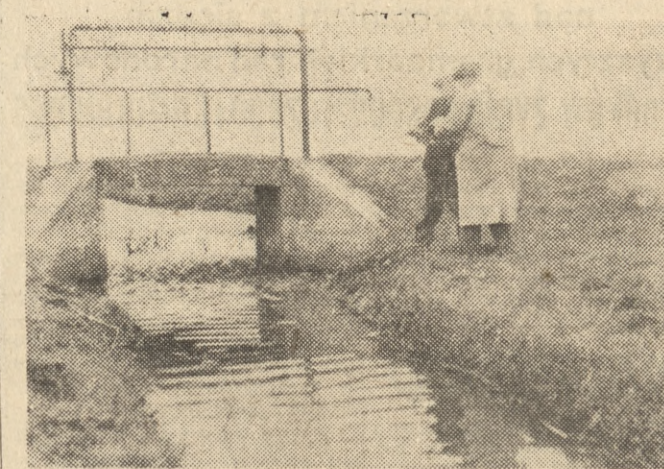
Przy oczyszczaniu tego kanału chłop z Nowych Dworów pracują już od kilku dni. Łącznie przepracują tu 240 dniówek.
