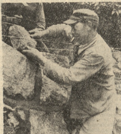
Murarz i przodujący rolnik w jednej osobie — Jan Bogucki postawił „na nogi” niszczący budynek.
