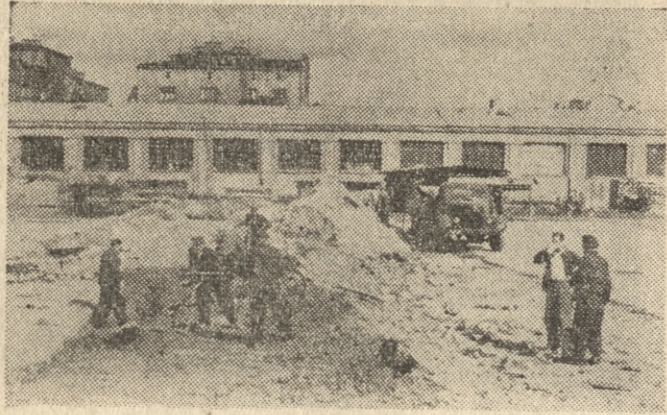
Ogólny widok placu budowy na terenie Międzynarodowych Targów Poznańskich.
