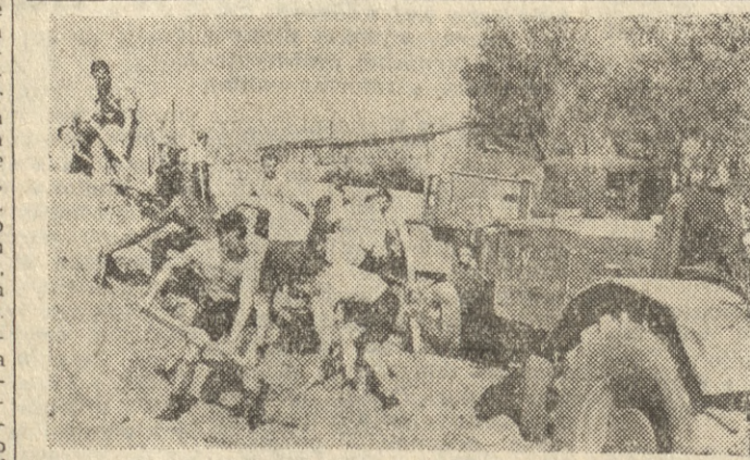
WRZESIEŃ — MIESIĄC BUDOWY WARSZAWY Na zdjęciu: pracownicy Warszawskiej Fabryki Gazów Technicznych zobowiązali się przepracować przy budowie stadionu sportowego przy ul. Zielonickiej 120 godzin.
