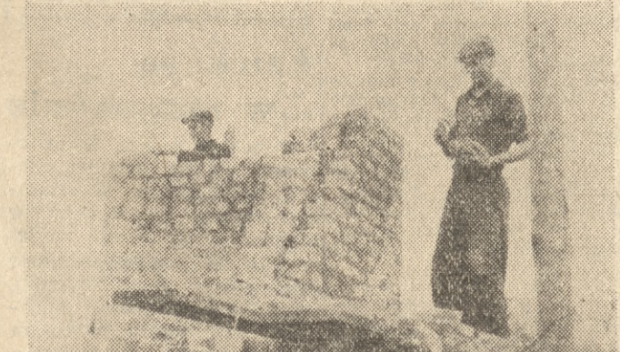
Polska Ludowa czerwienię nowymi murami jak długa i szeroka. Człowiek na rusztowaniu — to Michał Tomiak z Komornik. Praca przy budowie rodzinnego domku idzie razno naprzód.
