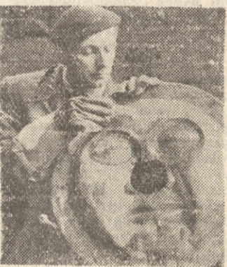
Pracownicy kuźni metalu — plastycznej ZBM w Gdańsku rozpoczęli prace przy rekonstrukcji czterech tarcz zegara Ratusza Głównego przy ul. Długiej. Dzięki pomysłom racjonalizatorskim, zastosowanym przy oczyszczaniu złoczonych części, zaoszczędzą oni około 1,4 kg złota. Na zdjęciu: mistrz — Marian Ogorzeja o czyszcza chemicznie maszkaron tarcz zegarowej. CAF. — fot. Kosycarz.
