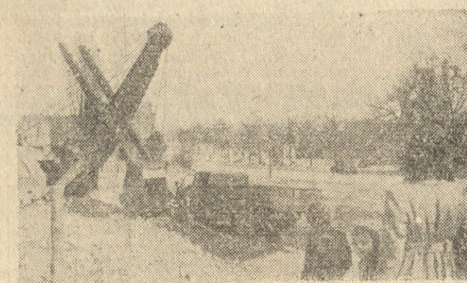
Tędy będzie biegła nowa trasa Poznania: most Marchlewskiego — most Dworcowy. Roboty ziemne przy budowie tej nowoczesnej, prostej i szerokiej arterii ukończone zostaną już w roku bieżącym.
