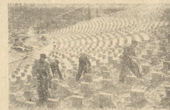
To nie są ruiny starożytnego Colosseum — to powstający w Poznaniu stadion „Stali” na 70 tys. osób, największa budowla sportowa w Wielkopolsce. Otwarcie tego obiektu nastąpi już w dniu 22 lipca. W dalszej przyszłości obok stadionu wybudowane będą boiska treningowe i meczowe koszykówki, siatkówki, korty tenisowe itp. Całość utworzy wielki park sportu i wypoczynku, który cągnąć się będzie aż po Dąbnie.
