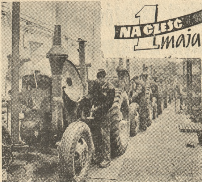
Dzięki realizacji zobowiązań załoga „Ursusa” wyprodukowała w II kwartale br. ponad plan 25 ciągników, 25 tzw. przekaźników mocy, tj. urządzeń, umożliwiających pracę sнопowalę przy pomocy ciągnika oraz 15 ton części zamiennych do ciągników. Na zdjęciu: hala montażu.
