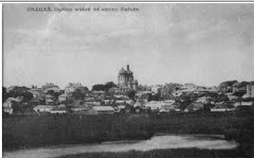
Zbaraż - widok ogólny od strony Zaluża
