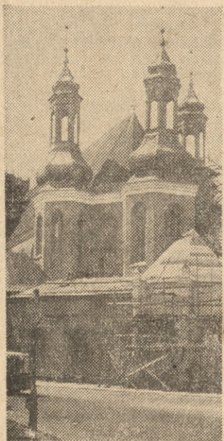
Katedra w odbudowie
