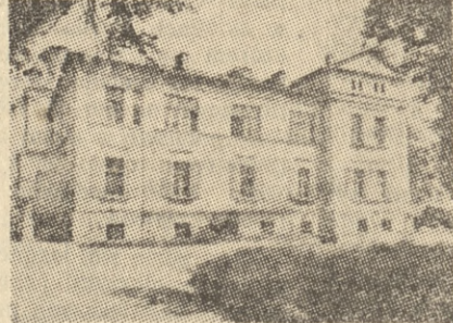
Główny budynek obserwatorium poznańskiego
