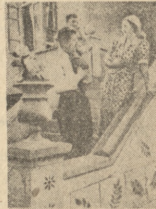
Rodzina brygadiera z kolchozu „Szroma” przed nowym budowanym domem
