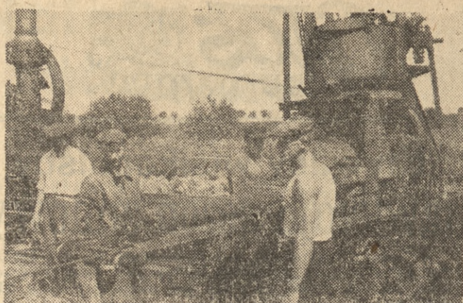
Agregat torfowy w kopalni GS Środa przy pracy. Z mechanicznej mieszarki wychodzi jednolita masa, która pokrojona daje cegiełki torfu.
