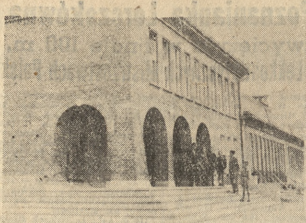
Internat Państwowego Technikum Hodowlanego w Środzice to nowoczesny gmach, zbudowany według wymagań socjalistycznej architektury.
