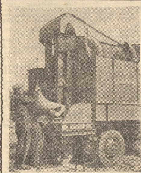
Ziarno, otrzymane z kombajnu, nie jest wystarczająco suche, aby można je było magazynować bez uprzedniego wysuszenia. Ogromne usługi przy suszeniu ziarna oddają dostarczane nam przez Związek Radziecki, wielkie, mechaniczne suszarnie.
