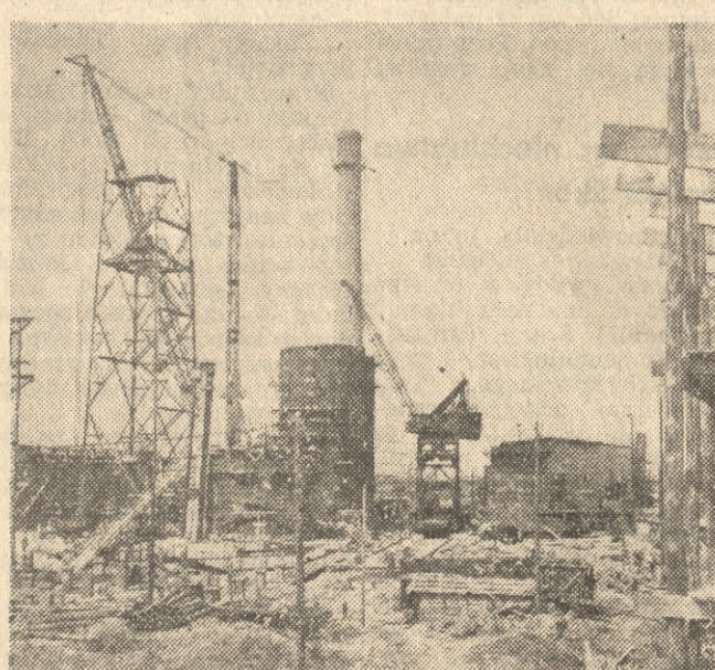
CAF — Fot. Zygm. Wdowiński Budowniczy Nowej Huty, realizującą chwałę Prezydium Rządu, przyspieszają budowę czołowych obiektów kombinatu.
