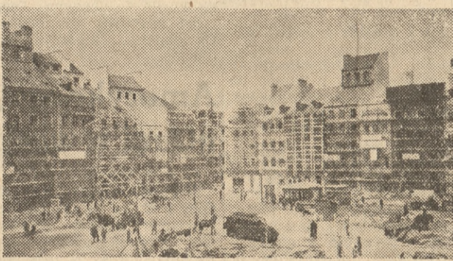
CAF — Fot. Dąbrowiecki Bez przerwy trwają prace przy odbudowie centralnej części Traktu Starej Warszawy — Rynku Starego Miasta. Na zdjęciu: fragment Rynku. Od lewej strony Kołtąta i Dekerta.
