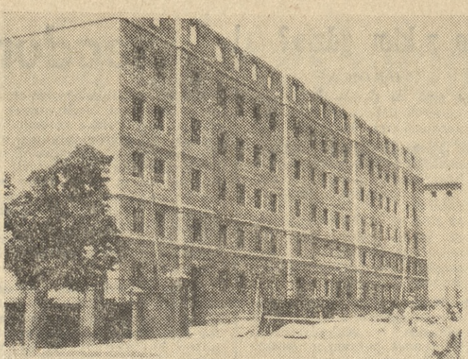
U zbiegu ulic Chudoby i Ratajczaka powstaje nowy budynek mieszkalny. Murarze pracują już na piątym piętrze. Wkrótce 198 nowych izb mieszkalnych oddanych zostanie do użytku robotników.
