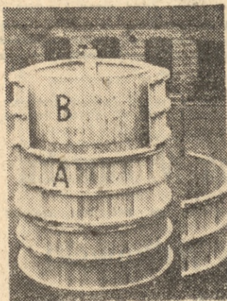
Forma drewniana do budowy silosów, zbudowana w warsztatach Rzemieślniczej Spółdzielni Metalowców w Nowym Tomyslu
