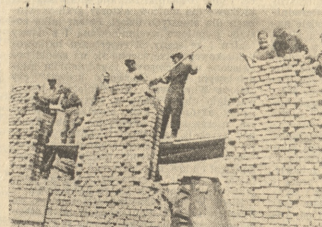
Brygada młodzieżowa Bogdana Cybrynika, budująca blok nr 30 na osiedlu B2, wykonuje przeciętnie 160% normy. Brygada podjęła zobowiązanie wymurowania dodatkowo 45 m 2 muru, skracając cykl produkcyjny o 76 roboczych godzin.
