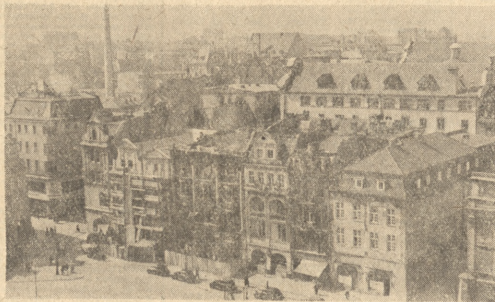
Odbudowane od strony zachodniej domy Starego Miasta są już w większości zamieszkałe.
