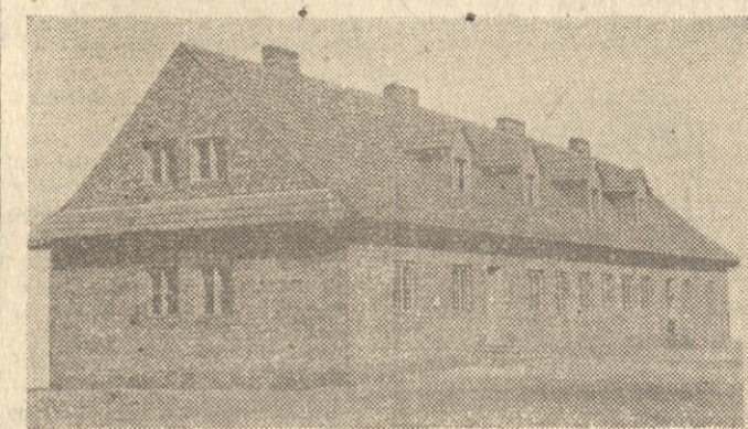
W trosce o warunki bytowe robotników sezonowych w sętkach Państwowych Gospodarstw Rolnych, wybudowano w ub. roku specjalne, nowoczesne wyposażone domy mieszkalne z kanalizacją, umywalkami, łazienkami, natryskami z zimną i gorącą wodą. Na zdjęciu: dom mieszkalny dla robotników sezonowych w PGR Strzeszynie pow. Poznań.
