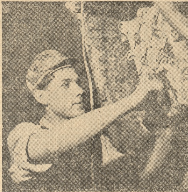
CAF — fot. Zdz. Wdowiński BUDOWA WARSZAWSKIEGO METRA Roboty przy budowie warszawskiego Metra postępują w szybkim tempie naprzód. W szeregu szybów ślasy górniczy prowadzą intensywną pracę przy drążeniu tak zwanych „korutarzy”, którymi w przyszłości przebiegać będą pociągi. Na zdjęciu: młody rębacz Henryk Jabłoński, opiekuje się aparaturą sygnalizacyjną maszyny wyciągowej.
