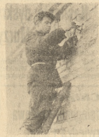
Elektromonter Bronisław Komorkiewicz przy ostatnich czynnościach przed włącze-niem Smoszewa do sieci elek-trycznej.
