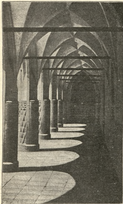
Podcienia w podwórzu Biblioteki Jagiellońskiej.
