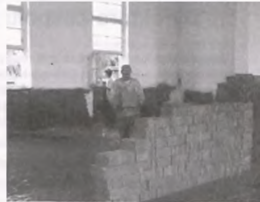
Na zdjęciu: gromadzenie cegły na budowę nowych toalet.
