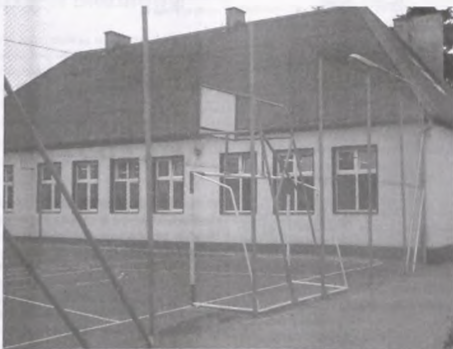
Po kilkunastu latach szkoła w Nowej Wsi doczekała się boiska sportowego. W głębi nowe okna (PCV) w pawilonie (na razie wymieniono tylko te od str. boiska).
