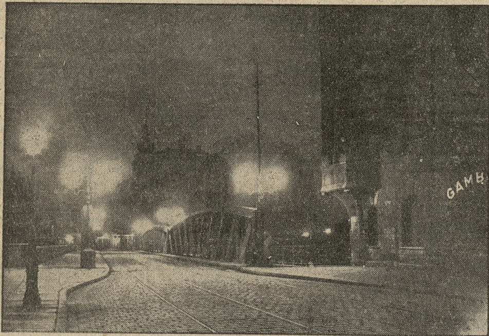
Powyżej mamy widok mostu od strony zachodniej, t. j. od ulicy Wielkiej.
