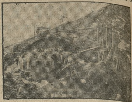
Kamieniołomy i budowa wież dla kolejki pod szczytem Kasprowego Wierchu.
