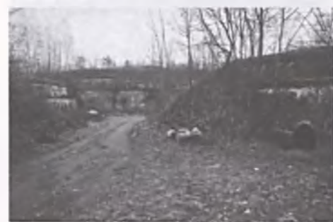
Koszary szyjowe typowego fortu pośredniego nowego typu. Od lewej: kaponiera szyjowa, wjazd główny oraz blokhauz obrony wjazdu. Fot. Przemysław Maćkowiak
