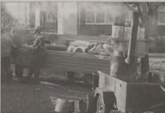
Pracownicy służb remontowych Spółdzielni „Tęcza” naprawiali dachy i szklili okna
