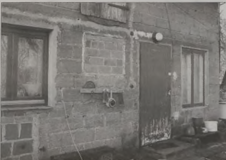
Stefania R. została zmuszona do opuszczenia tego budynku
