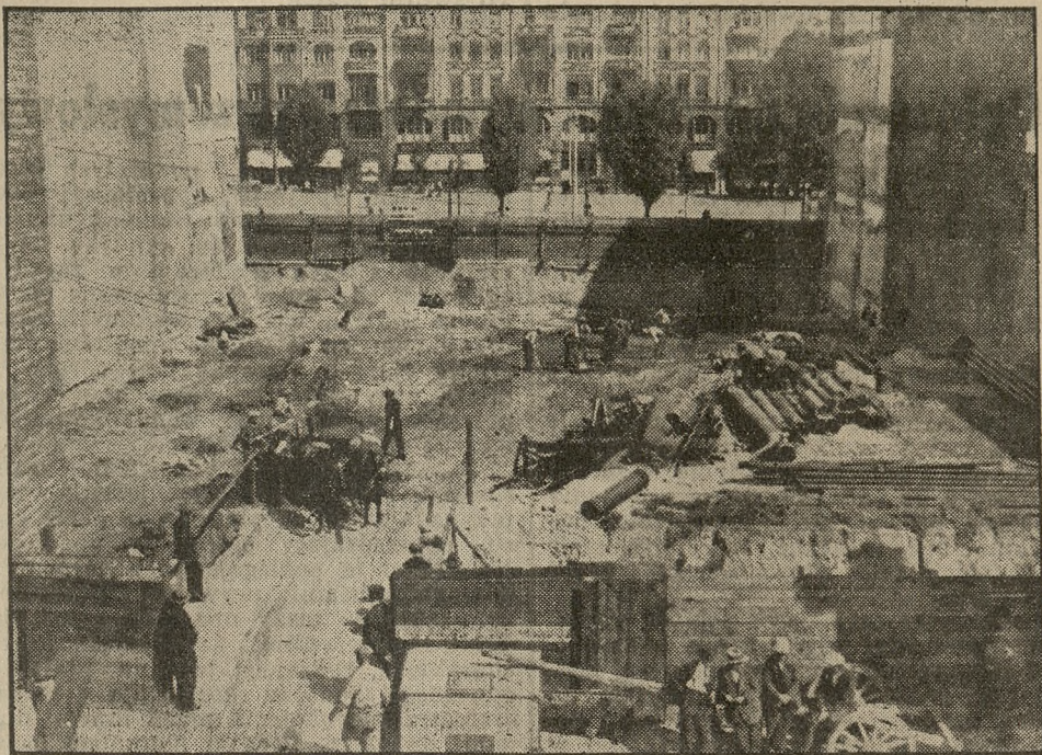
Tak wygląda teraz plac, na którym wzniesiony będzie gmach P. K. O.
