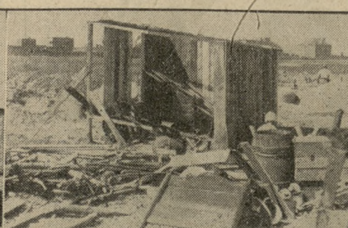
„Altanka” w trakcie budowy
