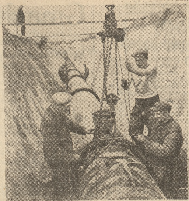
Rok bieżący ma zasadnicze znaczenie dla budowy największej inwestycji komunalnej planu 6-letniego w okręgu łódzkim i jednej z najważniejszych inwestycji komunalnych w kraju — wielkiego rurociągu wodnego, łączącego Łódź z Pilicą. Załoga budowniczych rurociągu nie szczędzi wysiłków, aby w pełni wykonać zalecenia zawarte w uchwałach Prezydium Rządu z dnia 23 grudnia 1950 r. w sprawie skrócenia o rok terminu oddania tej wielkiej budowy socjalizmu. Na zdjęciu: Przy dopasowywaniu rur pracują robotnicy z brygady Sobusiaka osiągnącej 280 procent normy.
