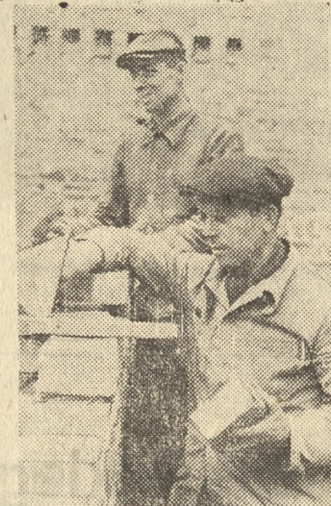
Gryśka i Grzegorz przy budowie
