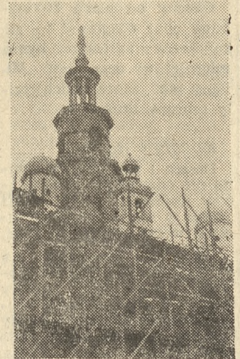
Z rusztowań wylaniają się odbudowane wieżyczki
